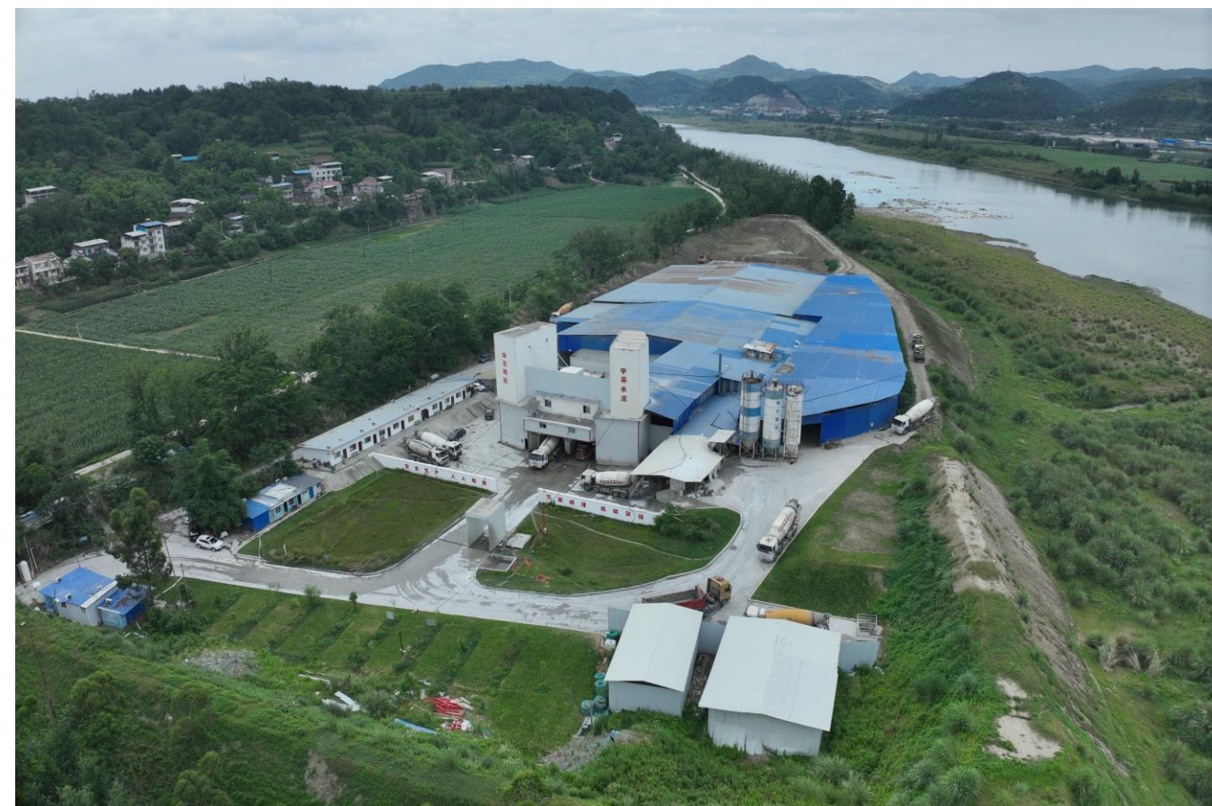
图 2-3-5 华石混凝土有限公司
